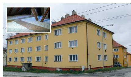
V prvním případě se jednalo o nevyužívanou půdu, na kterou byl přístup pouze průlezem po žebříku. U této realizace byl navržen způsob zateplení foukanou minerální izolací Supafil loft s revizními lávkami ke všem komínům, vikýřům, internetovým rozvodům, anténě apod.
